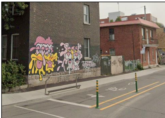
Approche ouest du carrefour de Bellechasse / de Châteaubriand
